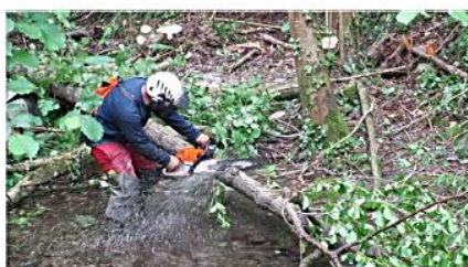
Travaux d'entretien de la rivière par l'équipe verte de l'EPTB Gardons : les végétaux susceptibles de faire obstacle à l'écoulement naturel du cours d'eau sont éliminés
