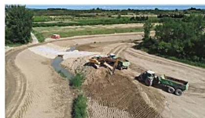
Travaux de suppression de digues défailtantes et renaturation du Briançon à Théziers (ci-dessus) - Prélèvement réalisé dans le cadre d'une étude sur les eaux souterraines (ci-contre)
