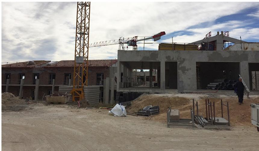
02 octobre 2018 : Aile Est couverture et menuiseries aluminium posées. Le bâtiment d'entrée prend forme
