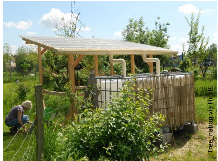
Cuves de récupération de l'eau de pluie qui s'égoutte sur l'abri
