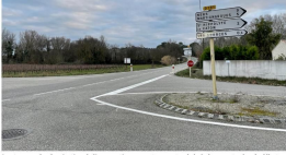
Les travaux de réhabilitation de la route départementale sont en cours de réalisation depuis début 2023. (Photo Corentin Migault)
